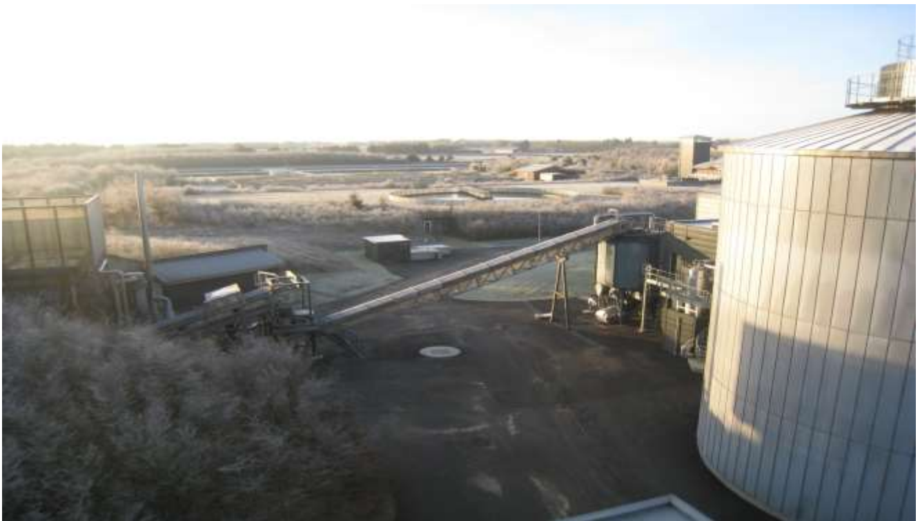
Biojätteiden vastaanottoasema. Taustalla jäteveden puhdistamon altaita.
