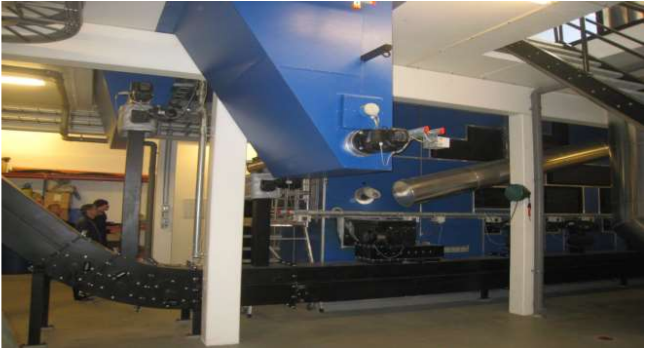
Given hakelämpölaitoksen kattila on Danstoker 5,6 MW
