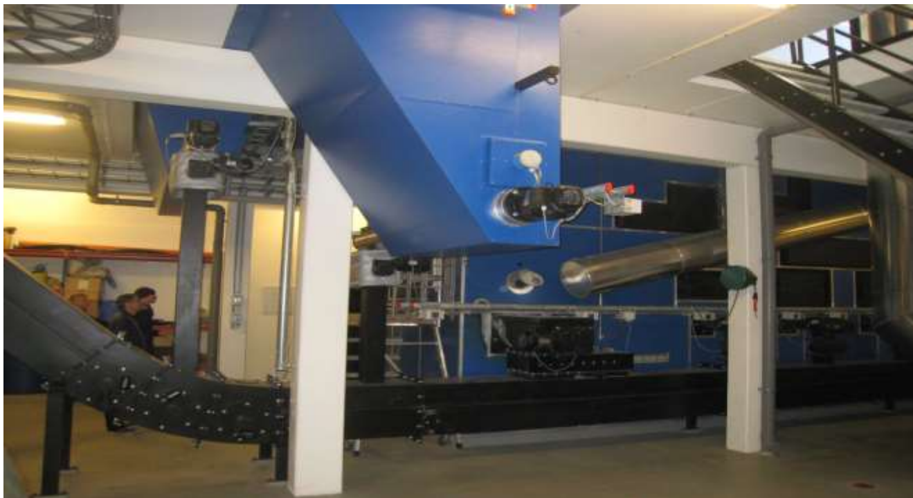
Given hakelämpölaitoksen kattila on Danstoker 5,6 MW
